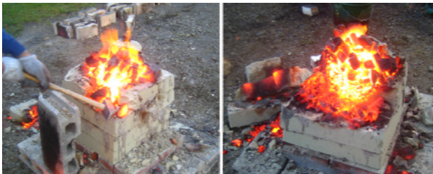
図6 オリピンレンガ炉の解体
