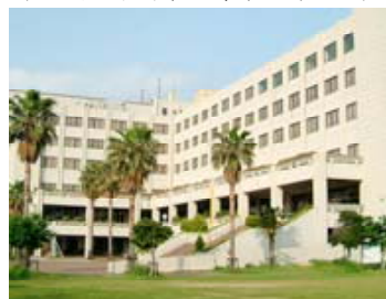
図4 兵庫県総合体育館
